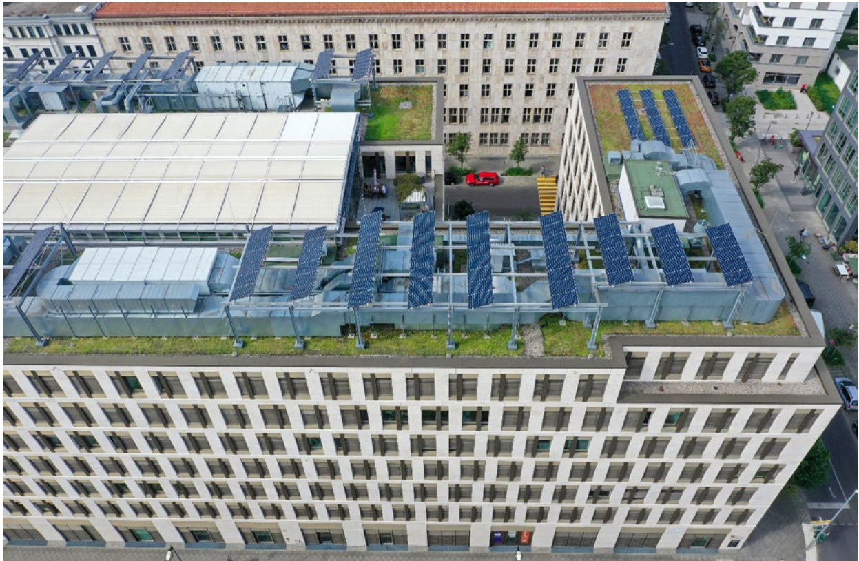
Abb. 4: EWDE Gebäudedach mit Photovoltaik, teilweise aufgeständert über Kühlungsanlagen, und Begrünung.
