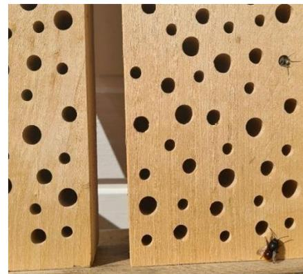
Bohrungen werden quer zur Maserung ausgeführt
